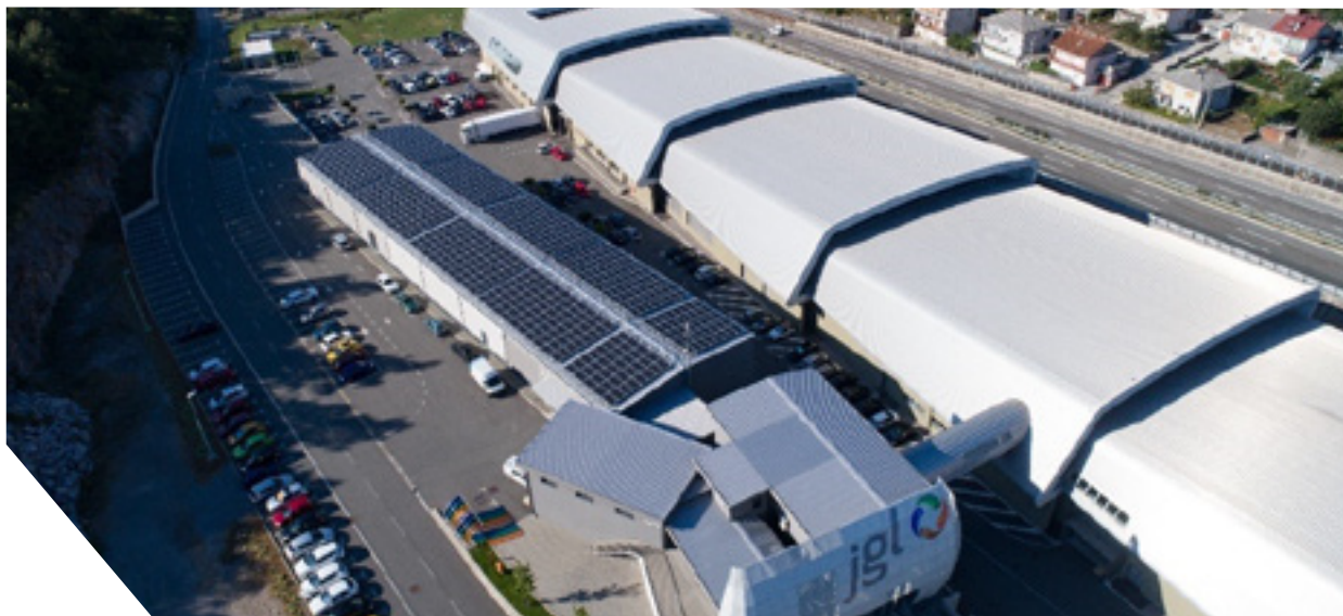
Fotonaponska elektrana na krovu objekta u JGL Pharma Valley kompleksu
