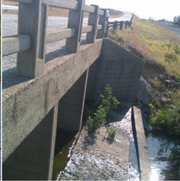
#9 Triple box Culvert est. 1923
