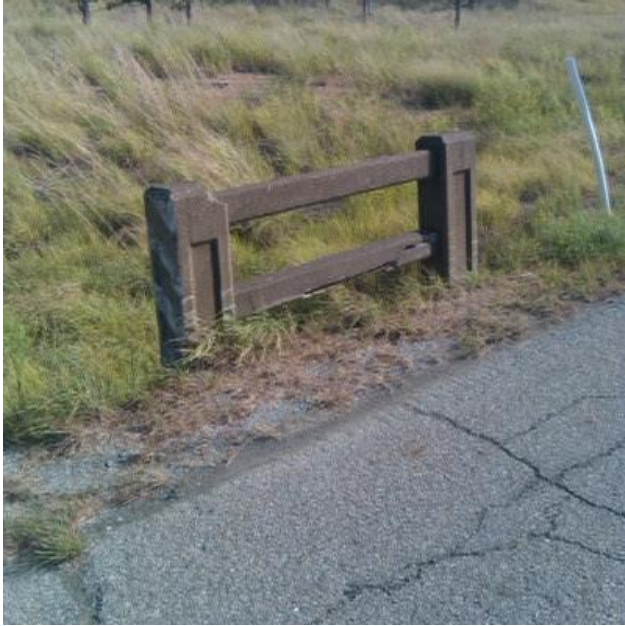
#8 Concrete Culvert est. 1923
